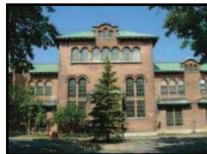
Bâtiment du complexe de l'aqueduc Atwater, Montréal, 2006. Photo : Martin Dubois, Patri-Arch.
