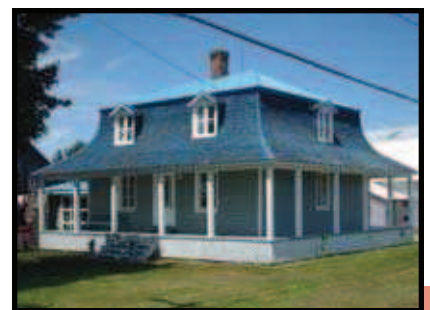
Résidence du secteur Saint-Étienne, Lévis. Photo : Patri-Arch.
